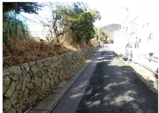
図 2-1-6 東側道路の現況写真
