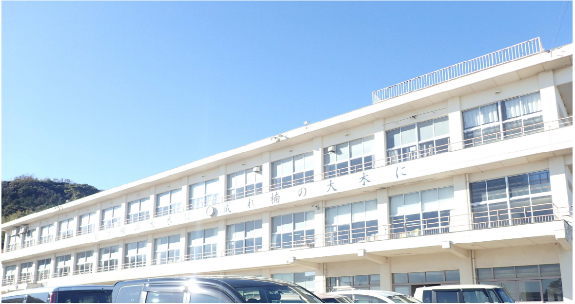
図 2-1-7 既設校舎（管理棟）の現況写真
