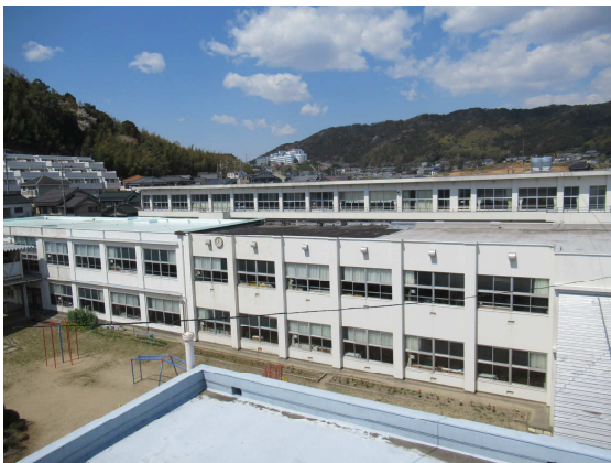
図 2-1-8 既設校舎（中棟、北棟）の現況写真
