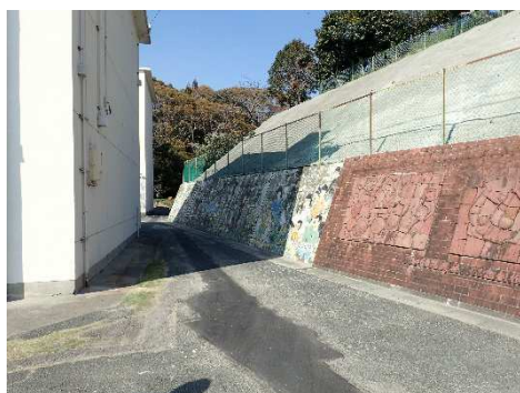
図 2-1-5 急傾斜地下端に設置されたのり面
