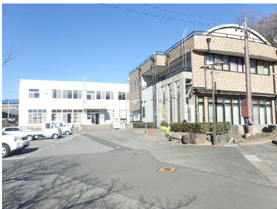
図 2-1-11 西浦公民館の現況写真
