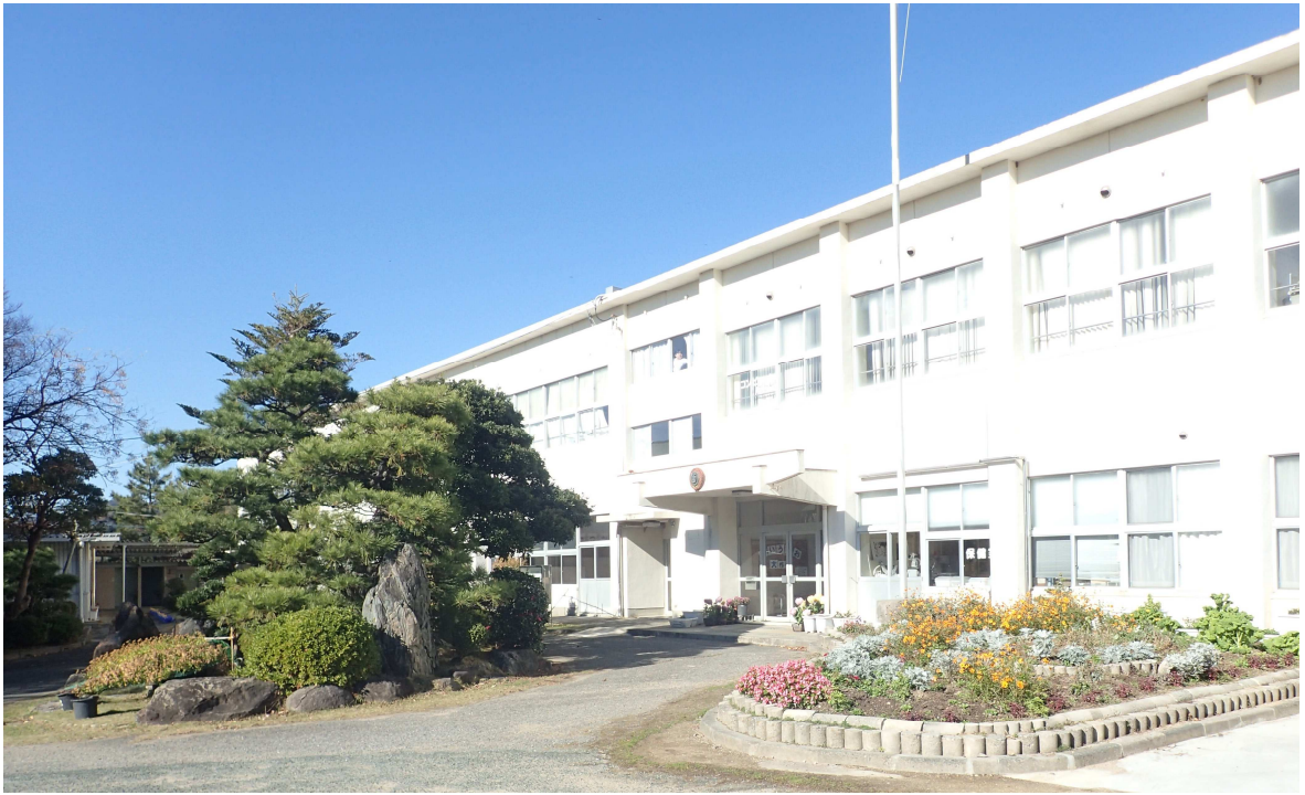
図 2-1-8 既設校舎（管理棟）の現況写真
