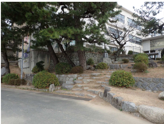
図 2-1-9 既設校舎からグラウンドへ降りる階段の現況写真
