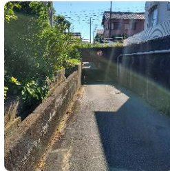
地域の 狭い地下道
