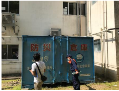
▲北校舎の防災倉庫の確認
