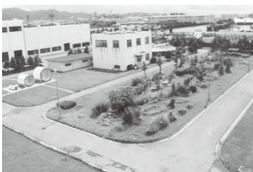
下水道浄化センター
