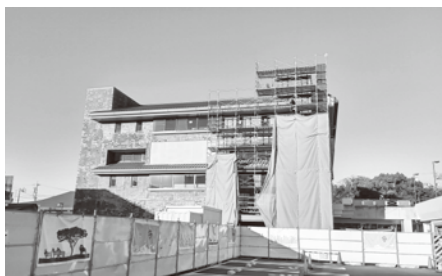
改修中の市民体育センター武道館
