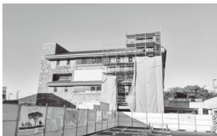
改修中の市民体育センター武道館
