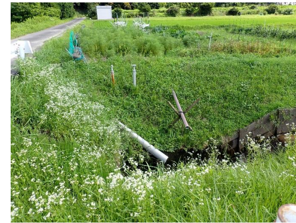
⑲排水管 落差工に設置
