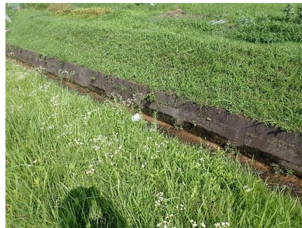
⑱水田からの排水
