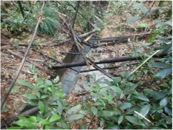
P-14 側溝 流水状況
