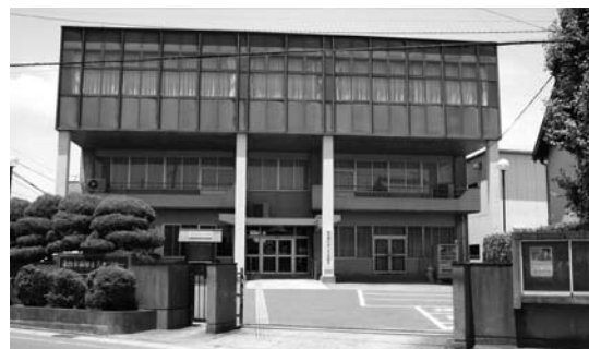
防災センターへの転用が予定されている西部市民センター
