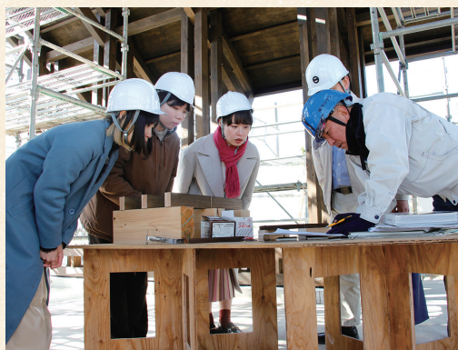
部材の取り付け方を検討
