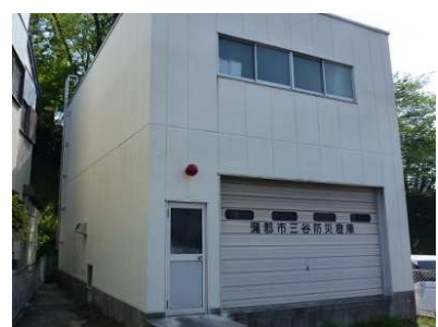
三谷防災倉庫
