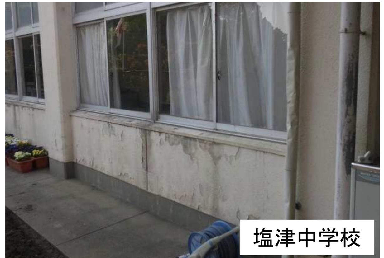
【工事費の例】 外壁吹付塗装の更新 約9,800円/m<sup>2</sup>
