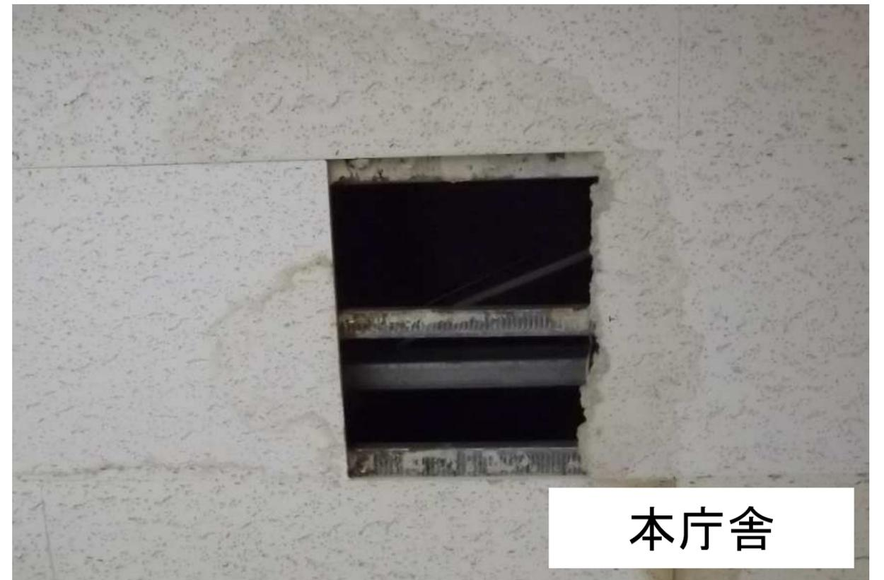
**【工事費の例】 天井板の更新(張り替え) 約6,400円/m<sup>2</sup>**
