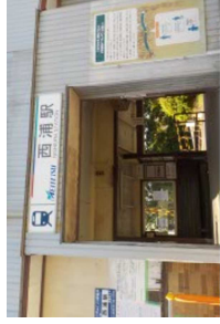
駅舎外部 (11).JPG
