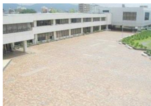
屋外高床広場
