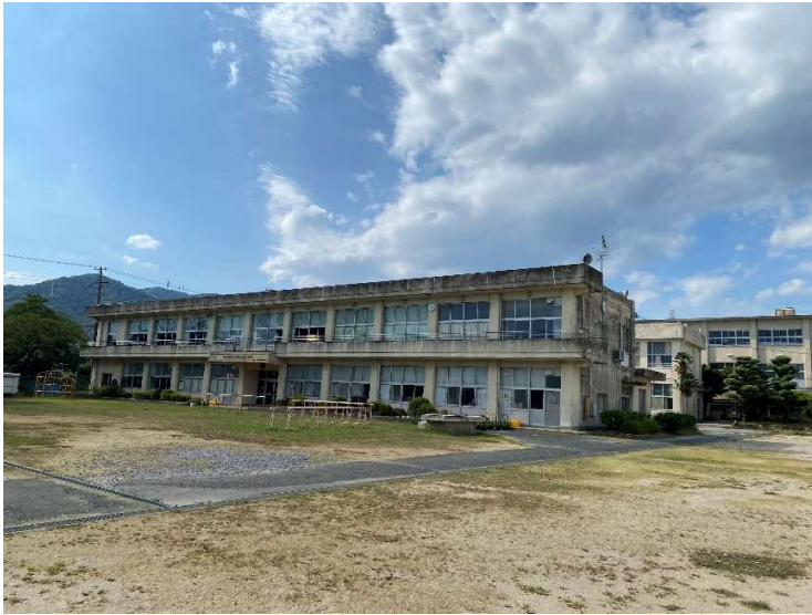
図 2-2-b 既存校舎（管理・教室棟）の現況写真
